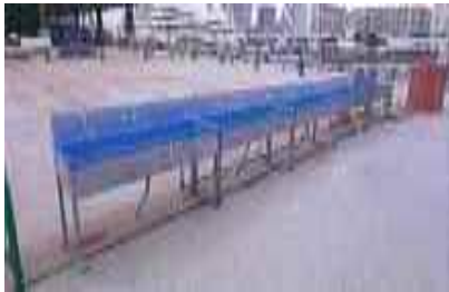
現場の手洗い場所の増設
