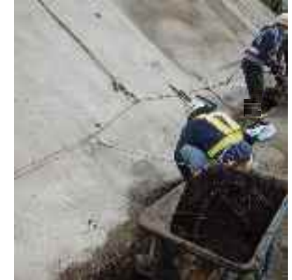
作業時なるべく離隔を確保
