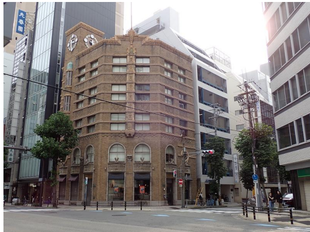
生駒ビルディング（生駒時計店）
