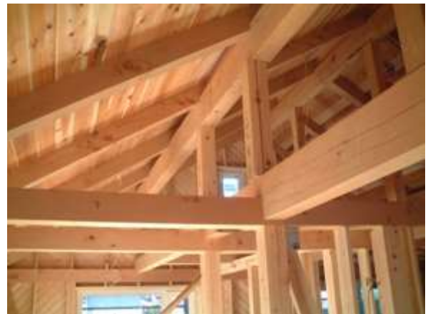
小屋裏の登り梁
