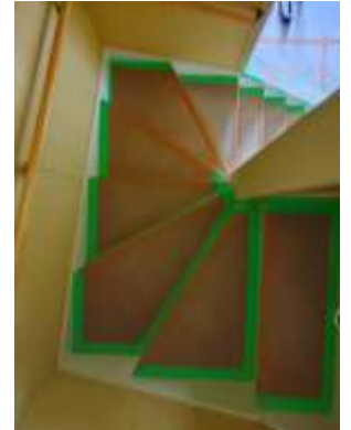
階段の角を養生
